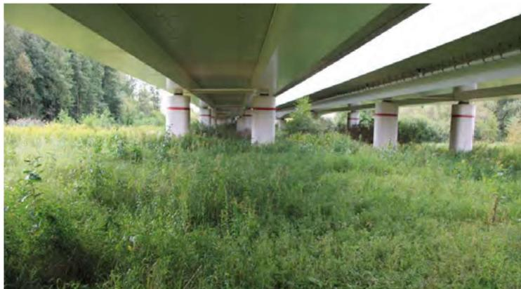
**Bild 1:** 2x2 spurig aufgespreizte Fahrbahn in Vorkopfbauweise.
